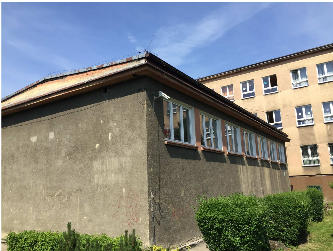
Fot. 4. Sala sportowa przeznaczona do rozbiórki – widok od strony wschodniej.
