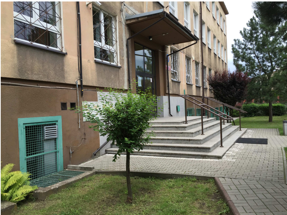
Fot. 5. Elewacja południowa. Główne wejście do budynku.
