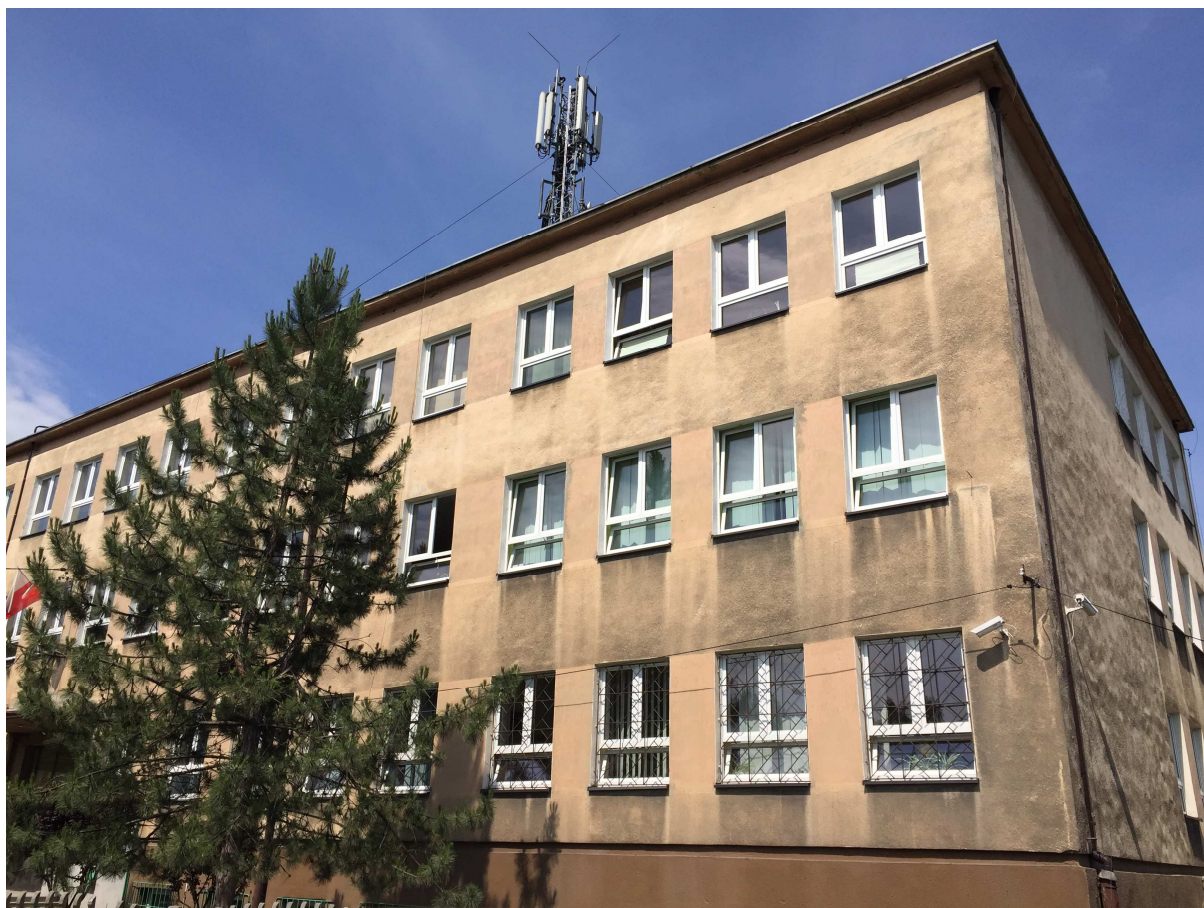
Fot. 1. Czterokondygnacyjny budynek Szkoły podstawowej elewacja frontowa - elewacja południowa
